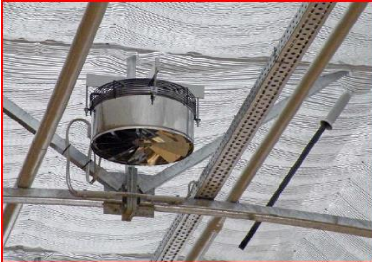
Slika : Uporaba ventilatorjev, ki omogočajo kroženje toplega zraka v rastlinjakih
