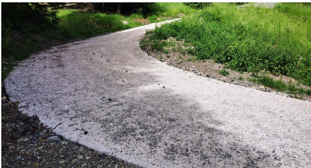
Slika 35: Betonska voziščna konstrukcija.
