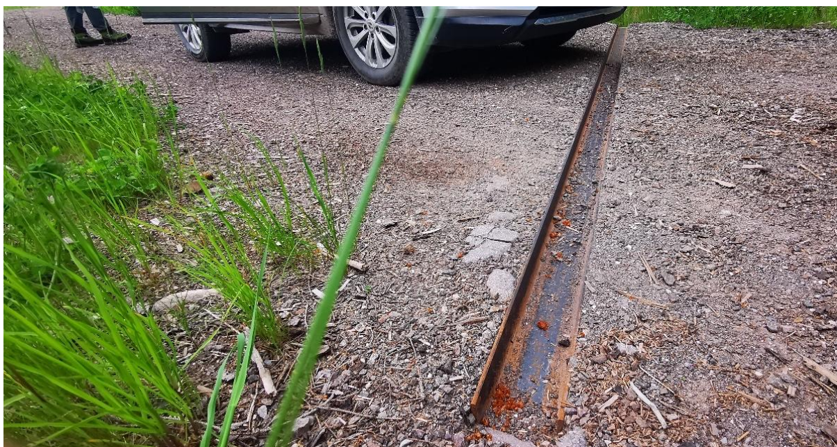
Slika 37: Za prečno odvodnjavanje uporabljajo kovinske dražnike.
