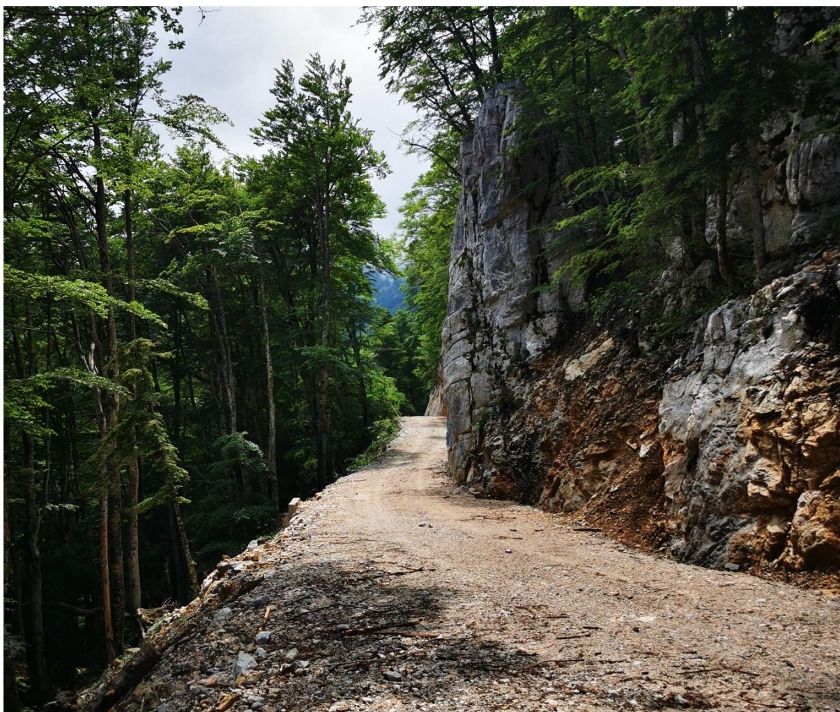
Slika 33: Primer novogradnje gozdne ceste ob skalni steni v nasipu, brez podpornih objektov.
