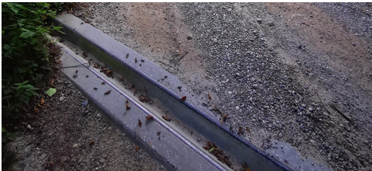
Slika 29: Vbetoniran dražnik v obliki črke V.
