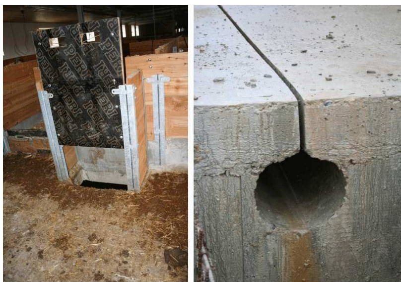
Slika 15: Praktična rešitev za odstranjevanje gnoja (levo) in kanal za odtekanje gnojnice ali vode na polnih tleh (desno)
