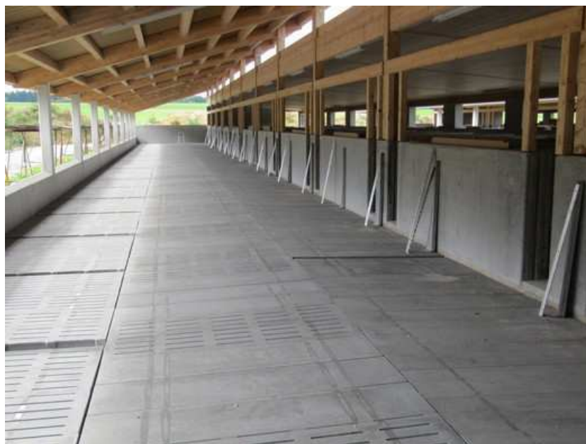
Slika 6: Polne betonske plošče, pomešane s polnimi elementi za ureditev ležalnega dela kotcev za pitanje
