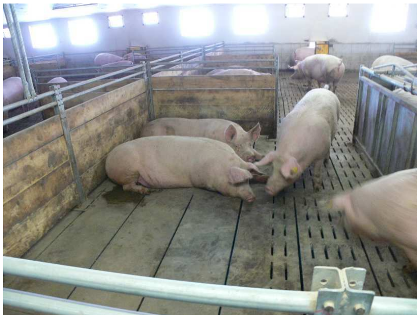
Slika 7: Kombinirana polna tla z drenažnimi režami in betonskimi rešetkami v hlevu za breje svinje
